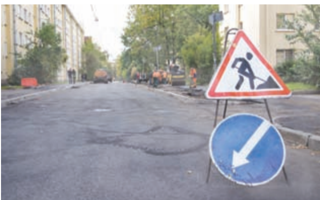
Ремонт дорожного полотна и тротуаров на ул. Оборонной.
